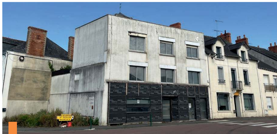
Le bâtiment du 2, place de la Mairie avant sa déconstruction cet été.
