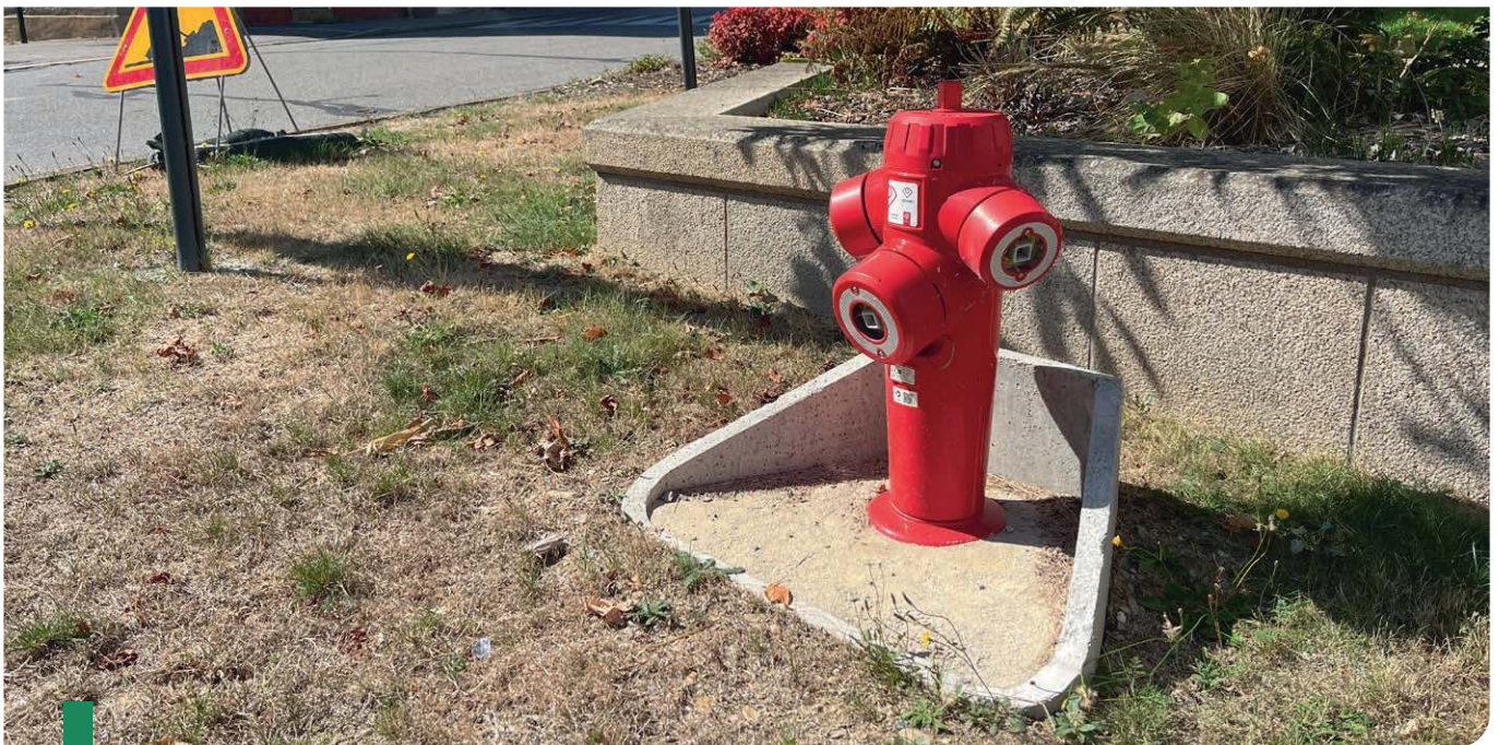
Récemment, un poteau incendie a été remplacé place de la Mairie.
